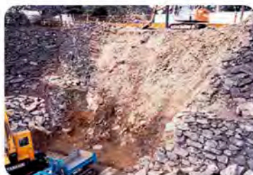
▲天守一の御門構 台石垣の解体と発掘調査
